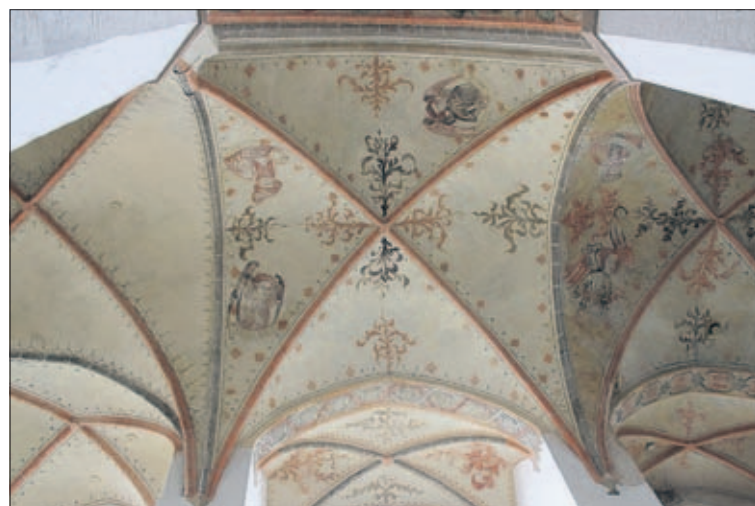
Die restaurierten Gewölbemalereien in den ersten beiden Jochen sind jetzt wieder in alter Schönheit zu bewundern. Fotos: A. Li.
